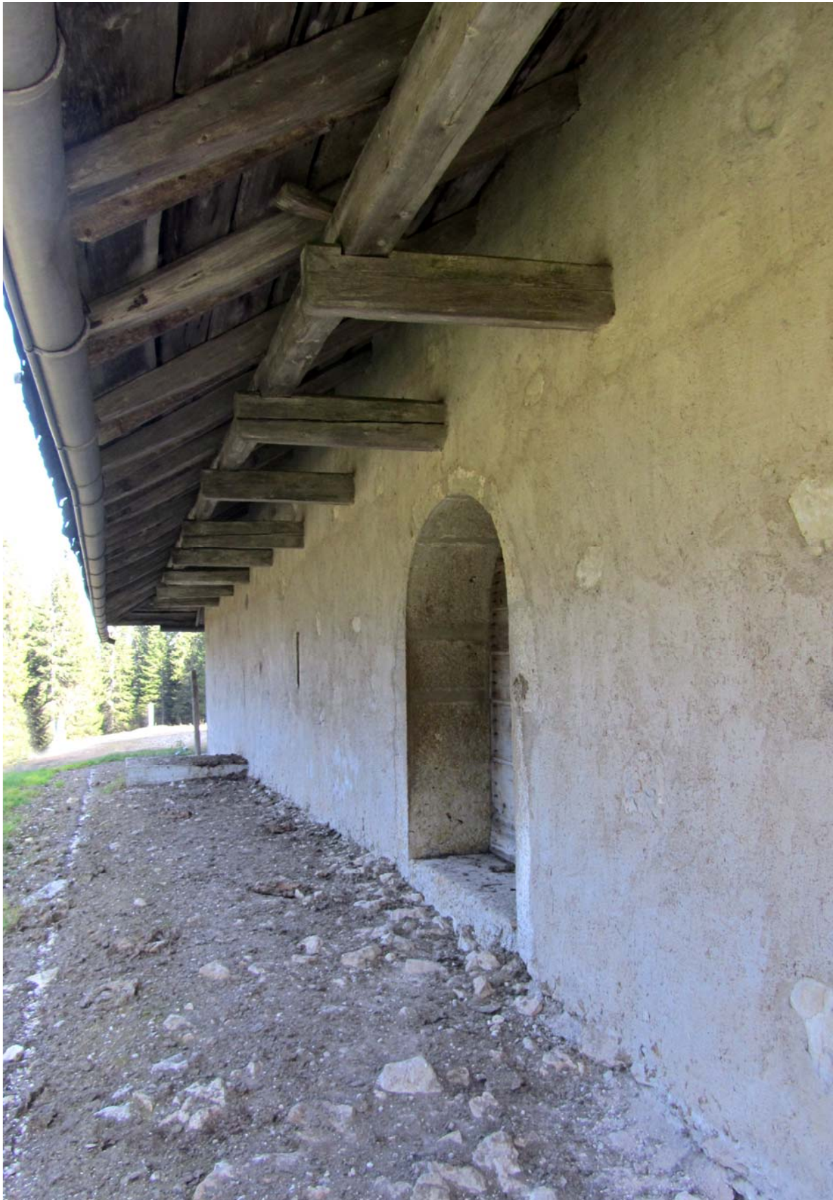
Façade arrière avec porte d'écurie voûtée. L'avant-toit offre de même une charpente superbe que l'on retrouve ci-dessous dans tout son vaste développement intérieur.
